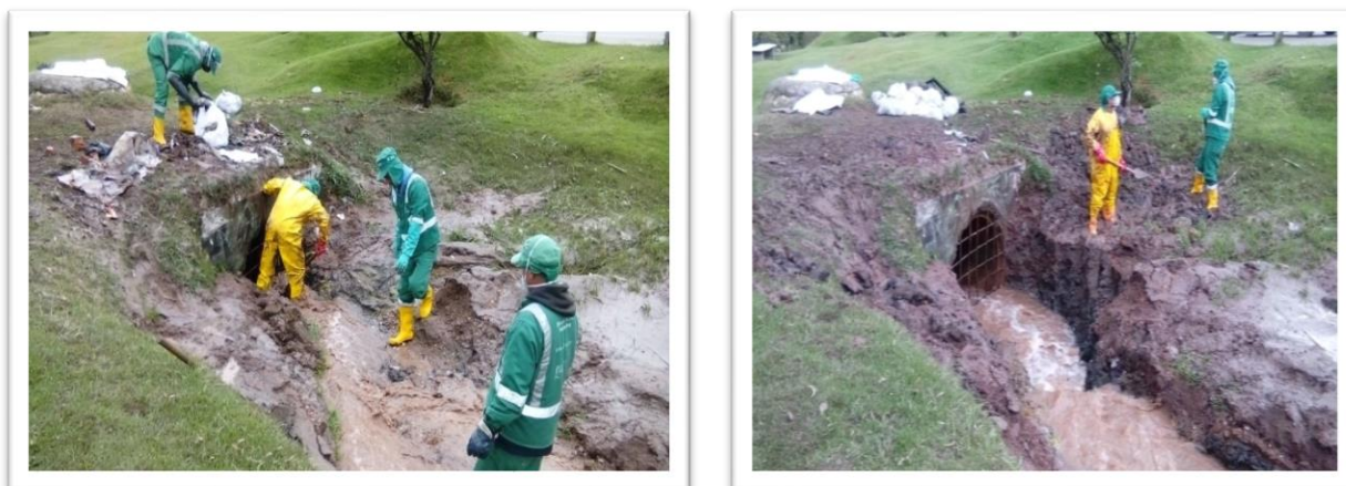
Fotos 12 y 13: Intervención manual en la quebrada Nueva Delhi (tramo: Carrera 15 Este entre Calle 61B Sur y rejilla de entrega)
