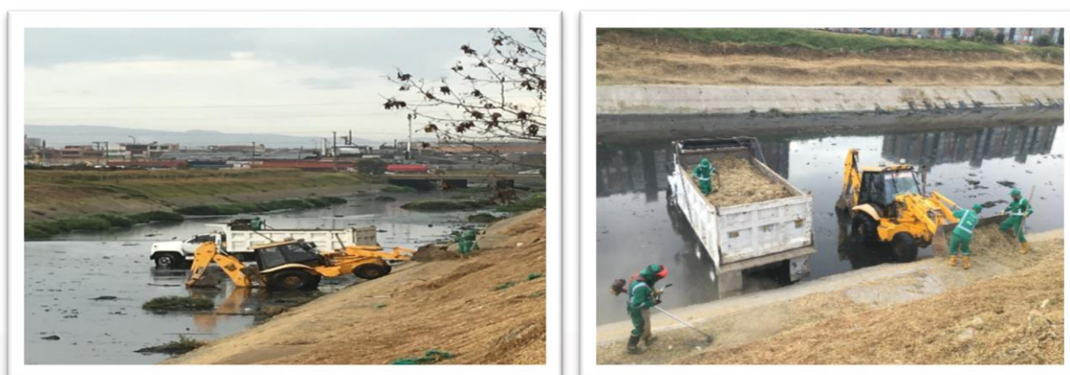
Fuente: IDIGER febrero 15 de 2016 Fotos (10) y (11) Intervención mecánica y corte de césped en el canal San Francisco en el tramo de la carrera 80A entre calle 13 y entrega al Río Fucha
