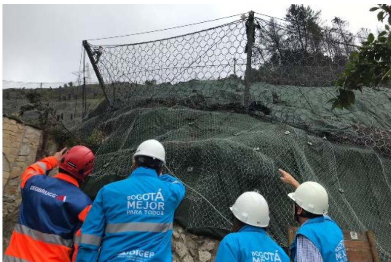
Fotografía 8. Verificación de obras de mitigación cerro de Monserrate Fuente: IDIGER
