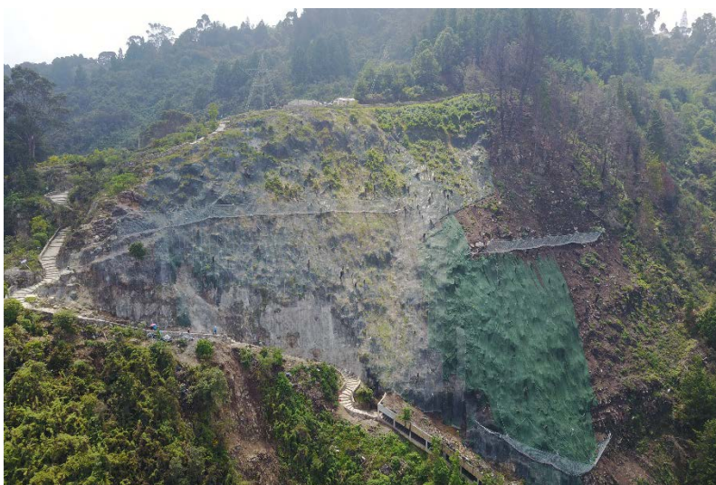
Fotografía 7. Obras para control de erosión, cerro de Monserrate Fuente: IDIGER
