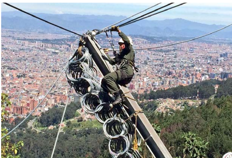
Fotografía 6. Instalación de barreras dinámicas Santuario de Monserrate Fuente: IDIGER
