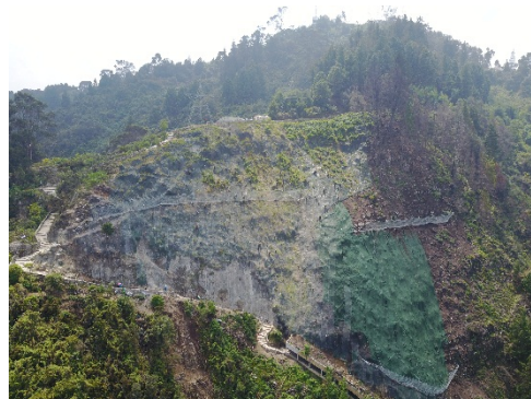
Foto 19. Control de erosión en Cerro de Monserrate Fuente. IDIGER. - Enero de 2017.
