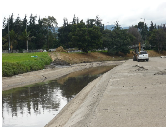
Foto 17. Limpieza Canal Salitre – Localidad Engativá
