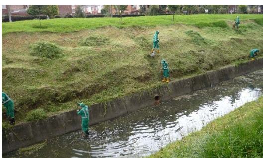
Foto 11. Limpieza Canal Bolivia – Localidad Engativá
