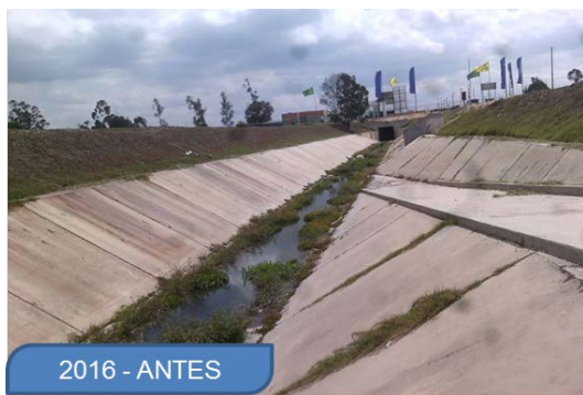
Foto 9. Canal Córdoba 2016 - antes
