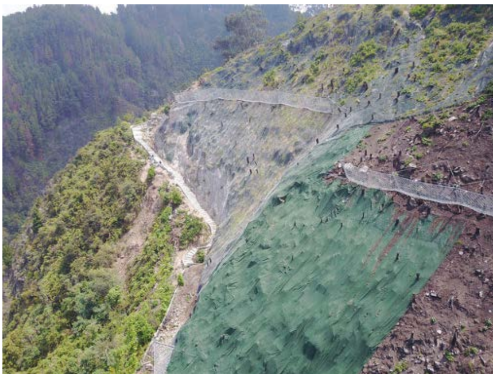
Foto 20. Control de erosión en Cerro de Monserrate Fuente. IDIGER. - Enero de 2017
