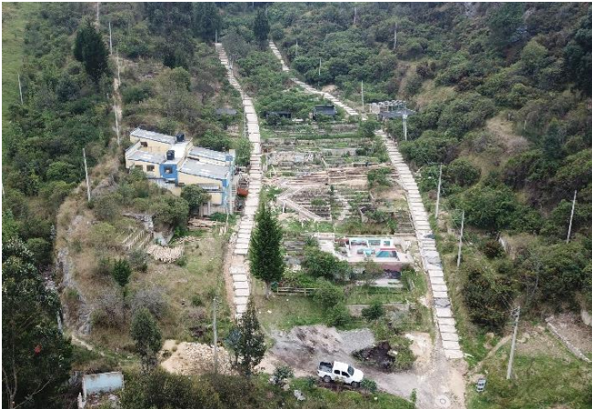
Bioingeniería – Polígono Corinto, localidad San Cristóbal
