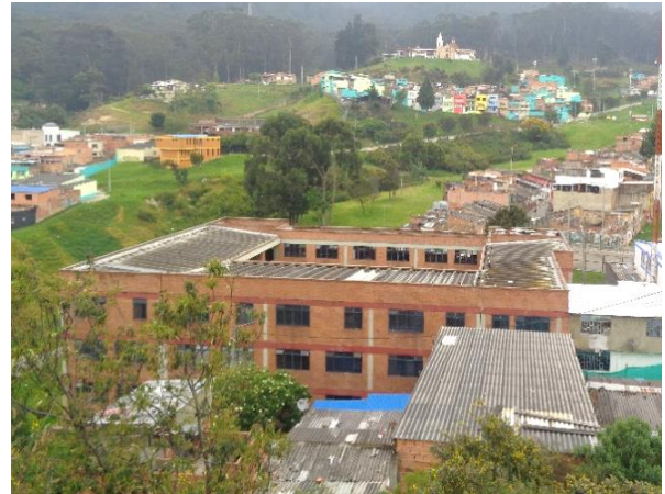
Colegio Los Pinos – Vulnerabilidad sísmica, localidad Santa Fé
