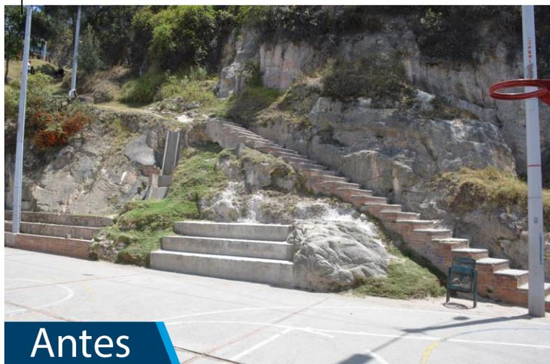
El Parque El Porvenir, de la localidad de Usme se localiza al lado de un talud de por lo menos 8 metros de altura que lo afectaba, debido a los procesos erosivos y desprendimientos de material rocoso que allí se presentaban.
