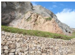
Muro en gavión
