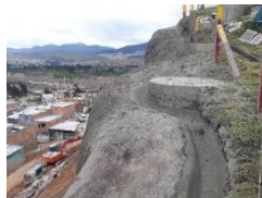
Cuneta en la corona del talud
