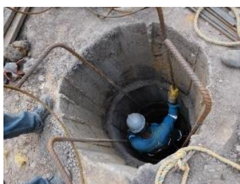
Construcción de Caisson
