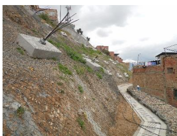
Cunetas y Drenes
