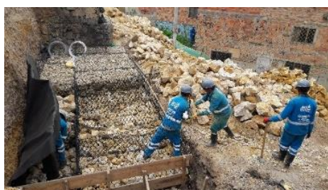
Instalación de Gaviones
