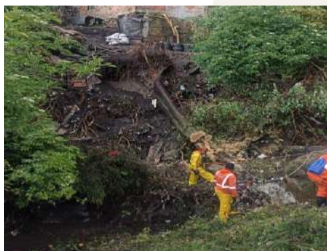
Apoya al evento SIRE 5385 del 30 de octubre 2021 repique de árbol sobre la quebrada Verejones
